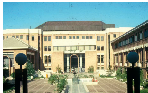
1991建成的清华大学图书馆三期工程。大玻璃顶设计被改大为小、分散组合。分散式小玻璃顶群藏在了现在的平屋顶造型里。
