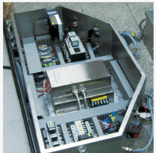
带冗余功能的变桨系统伺服驱动器柜
