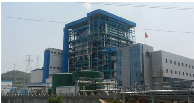
正在进行168小时考核运行的世界首台600兆瓦超临界循环流化床锅炉
