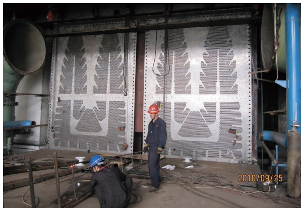
西柏坡电厂改造现场
