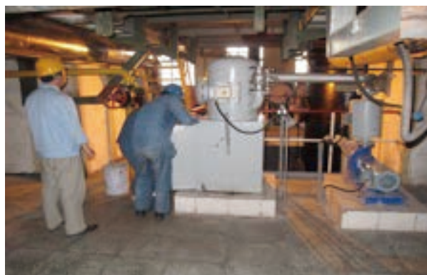
示范工程现场
