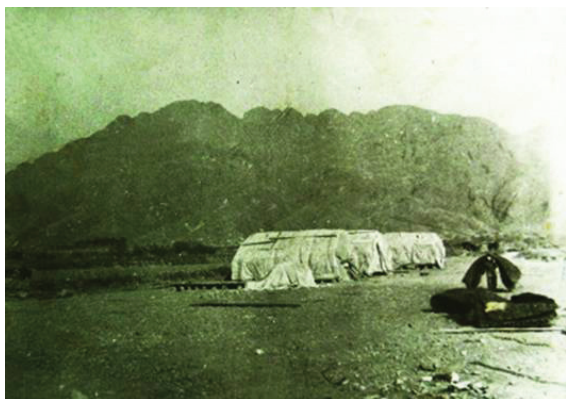
200号工地早期搭起的帐篷（摄于1960年）
