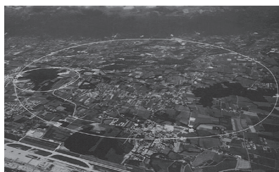
瑞士CERN的全图。在图中大圈地下100米处隧道中已经建成一个大型加速器LHC。图左下方是日内瓦国际机场的跑道。
