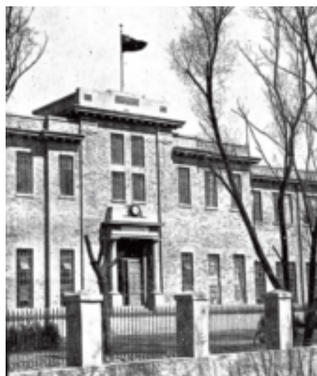
1934年建成的机械工程学系系馆
