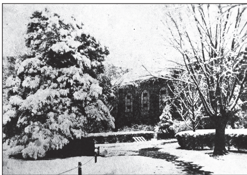
图6 原图书馆一期建筑门前的喷水塔移走后，水池栽上了大松树
