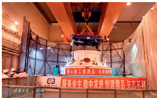
压力容器顶盖吊装现场
