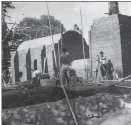
大炼钢铁时的情景：有小高炉、热风炉、烟囱。测量者为作者
