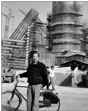
江欢成每天骑车到东方明珠塔建设工地
