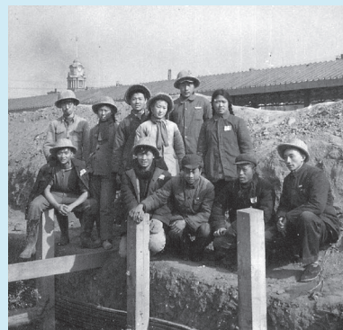
1961届土木系给排水专业同学参加首都迎接建国十周年大型市政工程施工。图为在天安门广场雨水、污水管线施工现场
