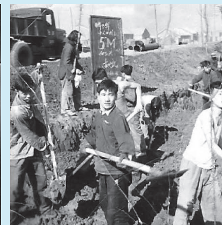
管道施工挖土方。黑板上写着：目标每人5m³
