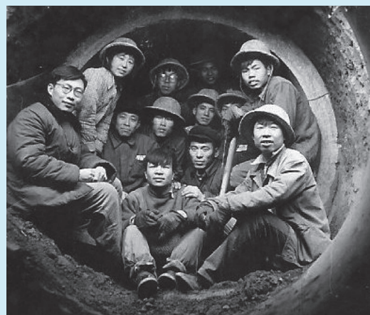
用顶进法成功穿越前门城墙，实现了管道对接。左1为时任系团委书记方惠坚
