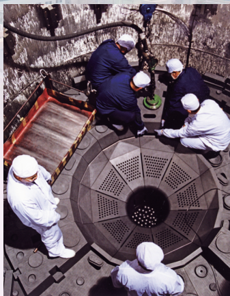
▲ 10兆瓦高温气冷堆石墨堆内构件安装（1999）
