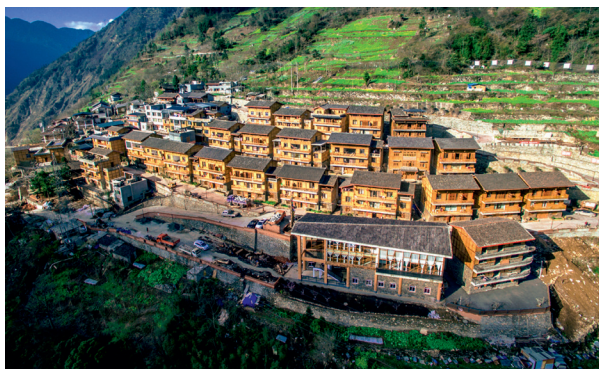
重建后的雪山村全景
