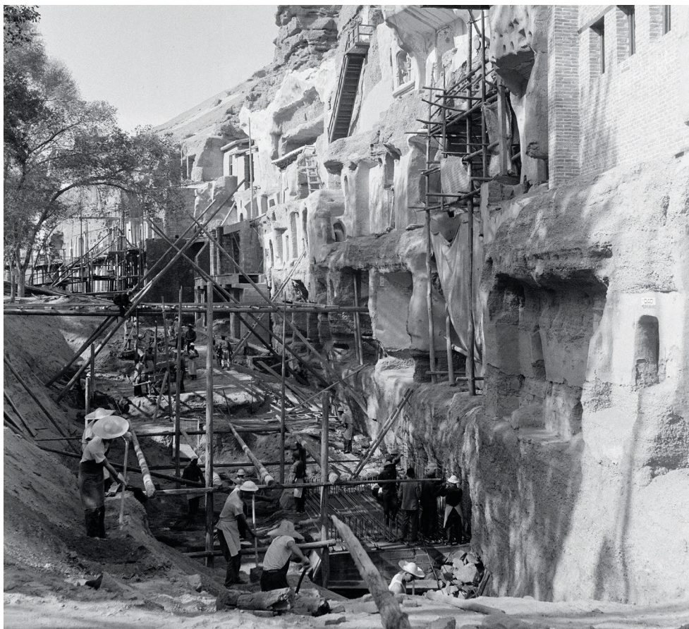
工作人员对莫高窟部分洞窟进行加固施工（1964年7月8日摄）。
