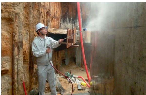
海口市现浇综合管廊施工
