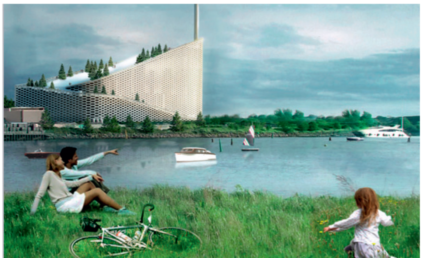
丹麦哥本哈根的 Amager 垃圾发电厂 (CHP) 效率高达 90% 以上。
