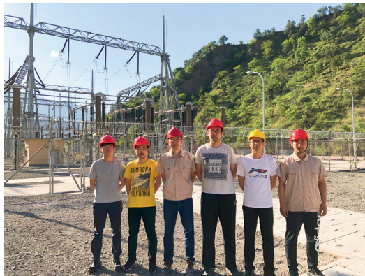
巴基斯坦尼鲁姆 - 杰卢姆水电项目现场（左 1 为申昊）
