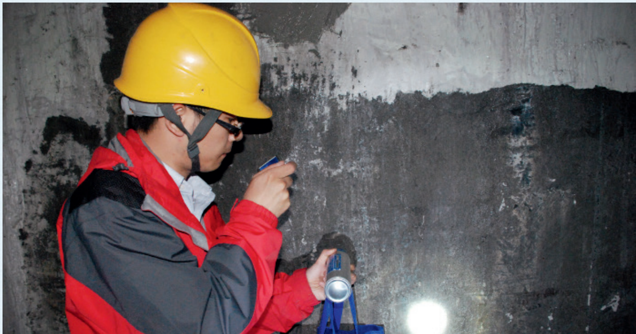
向家坝电梯竖井检测效果
