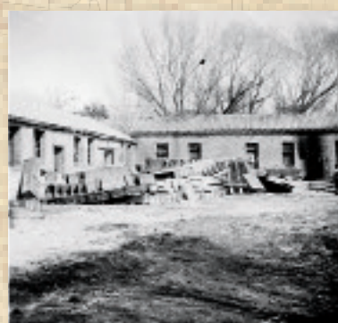
体育馆全部铁衣柜被弃之室外任其锈烂
