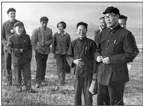
1966年上半年，蒋南翔校长视察绵阳分校建设工地，解沛基（前排右2）作为学校筹建绵阳分校负责人介绍情况
